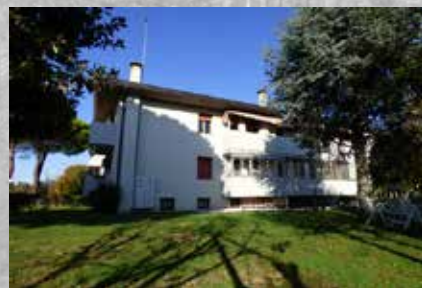
PONTE SAN NICOLO'
